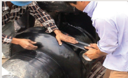
Bảo vệ chống ăn mòn cho ống thép và phụ kiện ống (co, tê, van, mặt bích,...)
